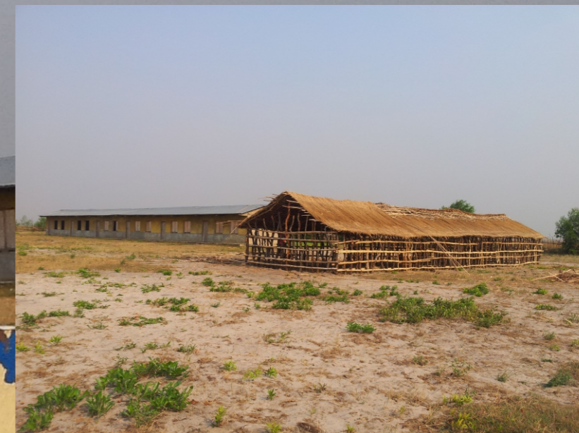
Das Provisorium für 2 Klassen wird bald ersetzt
