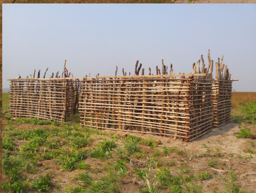
Das Lehrerhaus für 2 Familien im „Rohbau“.
