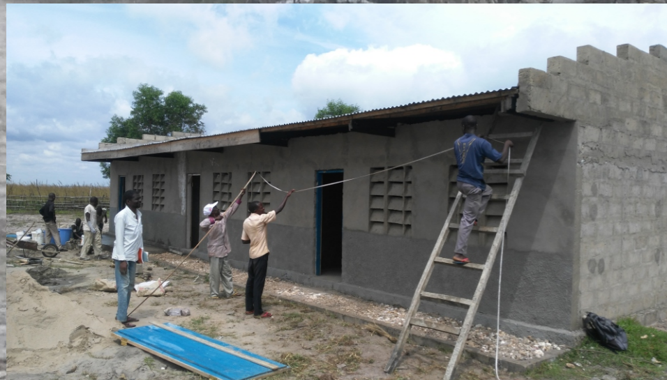
Das zweite Schulgebäude entsteht.
